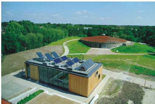
Gläsernes Heizhaus und Mehrzweckspeicher
